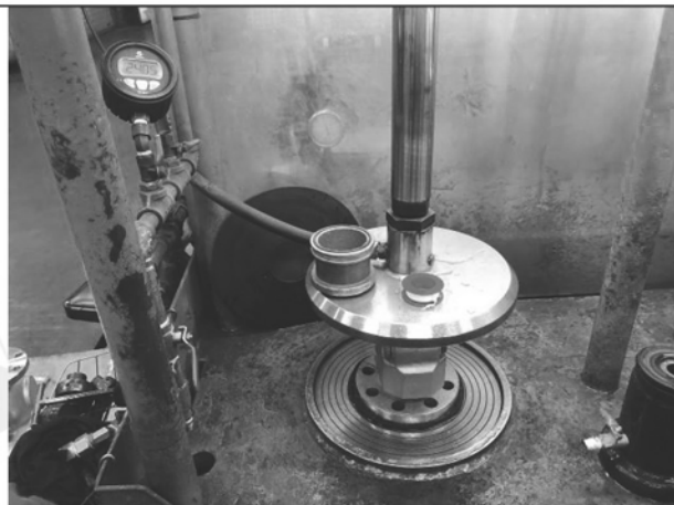
照片 B：測試架設
