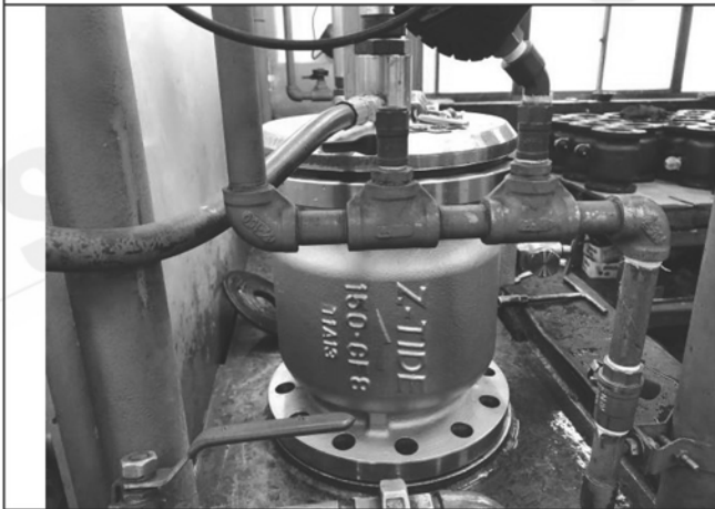
照片 I：測試架設
