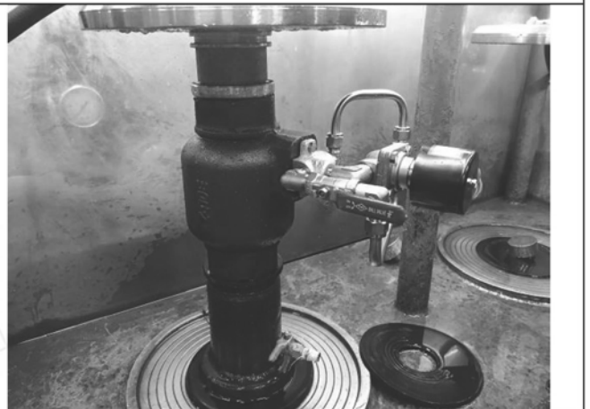
照片 J：測試架設
