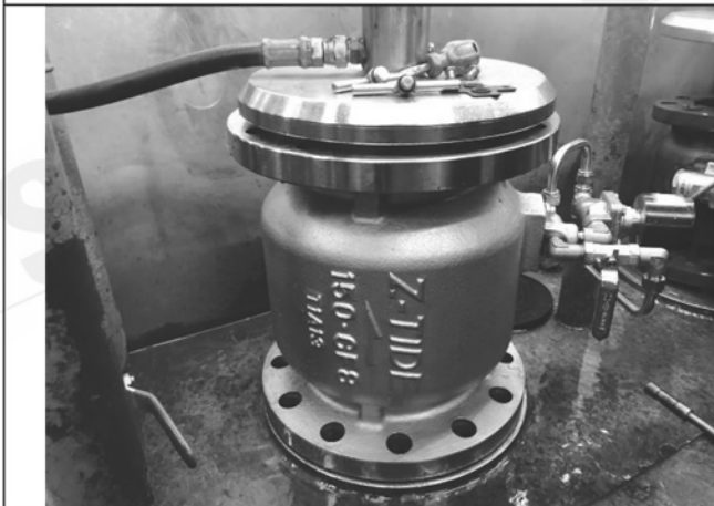
照片 I：測試架設
