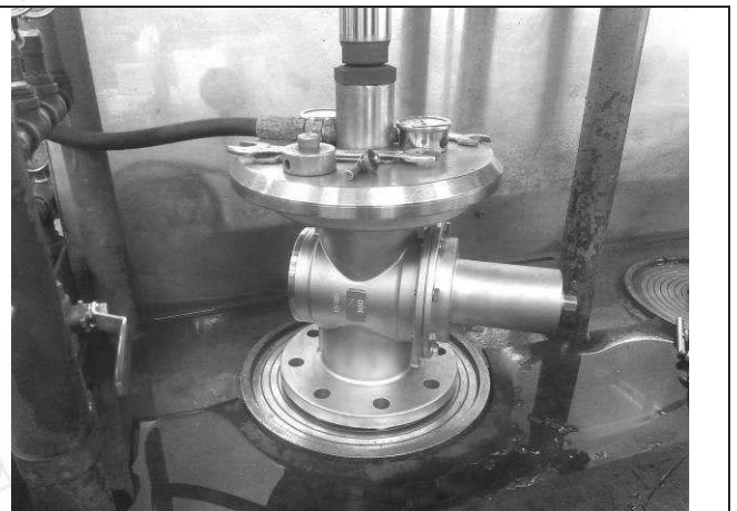
照片 B：測試架設-1
