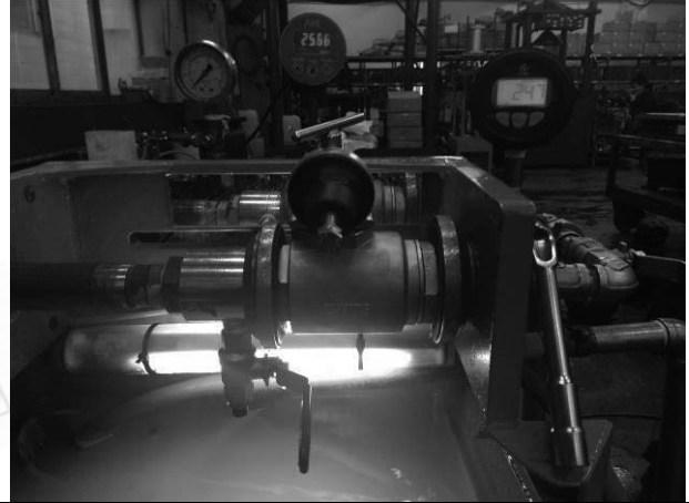
照片 J：測試架設
